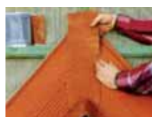
Sellado de limahoyas Sealing of valleys Scellement de noues
