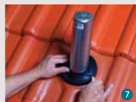
Instalar el sujetacables por debajo del borde del diámetro utilizado. Install the cable tie below the border of the used diameter. Installer le serre-câbles sous le bord du diamètre utilisé.
