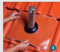
Presionar el producto por encima de la penetración en el tejado. Push the product over the roof penetration. Appuyer sur le produit au-dessus de la pénétration.
