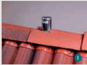
Situación inicial. Initial situation. Situation initiale.
