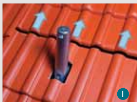
Situación inicial. Initial situation. Situation initiale.
