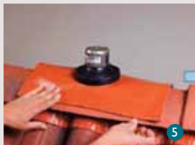
Moldear el Wakaflex® sobre las tejas sin generar tensiones. Mould Wakaflex® completely onto tiles without tension. Mouler complètement Wakaflex® sur les tuiles sans tension.
